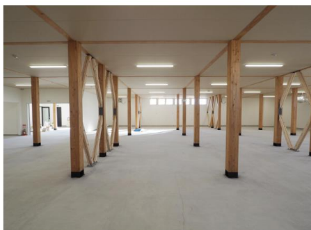
1階の柱は210ミリ角。万が一の火災時であっても、柱の中央まで焼けるまでに確実に避難の時間を確保する「燃え代設計」を行うことで、木の構造を見せながら必要な耐火性能を実現しています。
